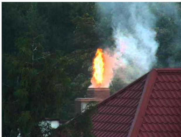
Rys. 3. Pożar przewodu kominowego
