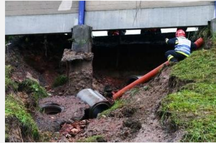
Autostrada A4 w rejonie Brzęczkowic (Jaworzno, https://www.facebook.com/jaworznoPL/posts/763562103833473/?locale=pt_BR&_rdr )
