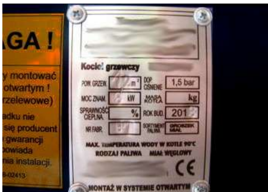
Rysunek 153. Zdjęcie tabliczki znamionowej kotła
